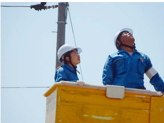
高所作業車に乗って
