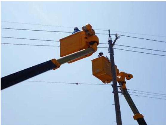
電柱の金具を取り付けました
