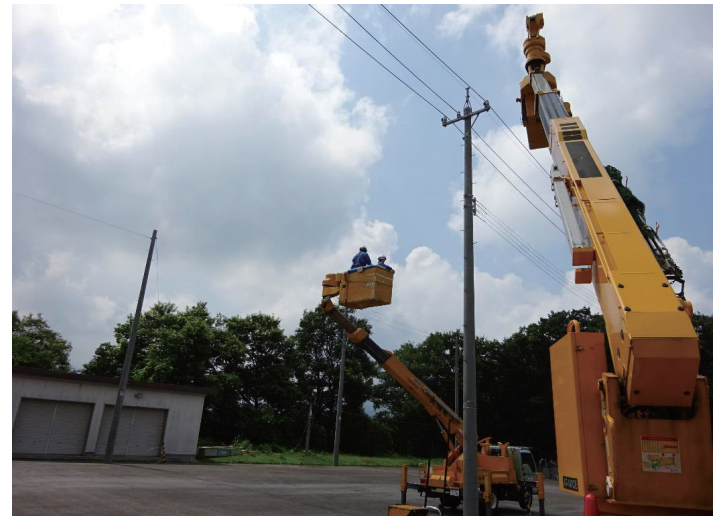
高所作業車に乗って電柱の上で作業
