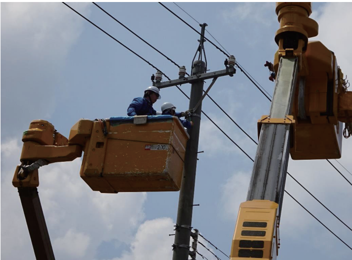
高所作業車に乗って電柱の上で作業
