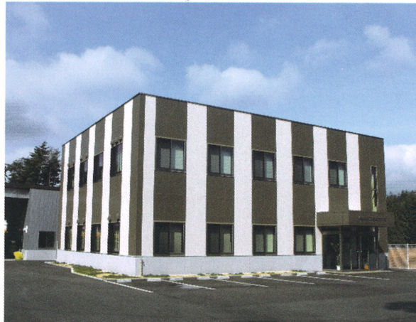
〈平成29年8月 当社輪島営業所・能登工事所新築〉
